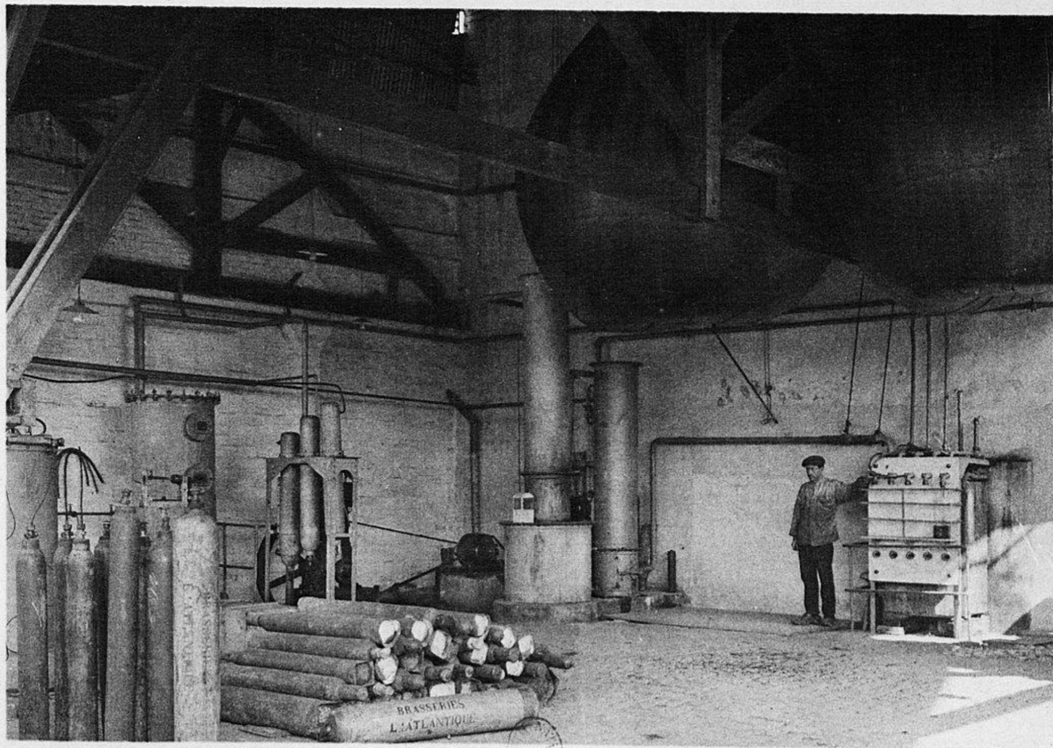
RÉCUPÉRATION, LIQUÉFACTION ET MISE EN TUBES DE L'ACIDE CARBONIQUE
